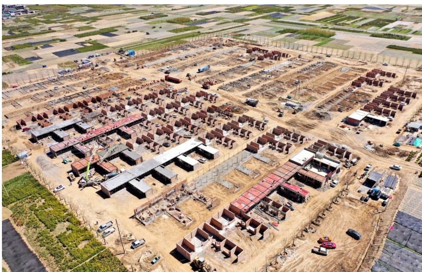
5月以来,岷县十里镇2024年生态及地质灾害避险搬迁建设工地一派繁忙景象,工人及机械来回穿梭,为确保10月底前实现搬迁入住抢抓工期、加速推进。据了解,该安置点建成后,将集中安置周家山、的古录、上庄等6个村13个地质灾害隐患点威胁区群众162户651人。
