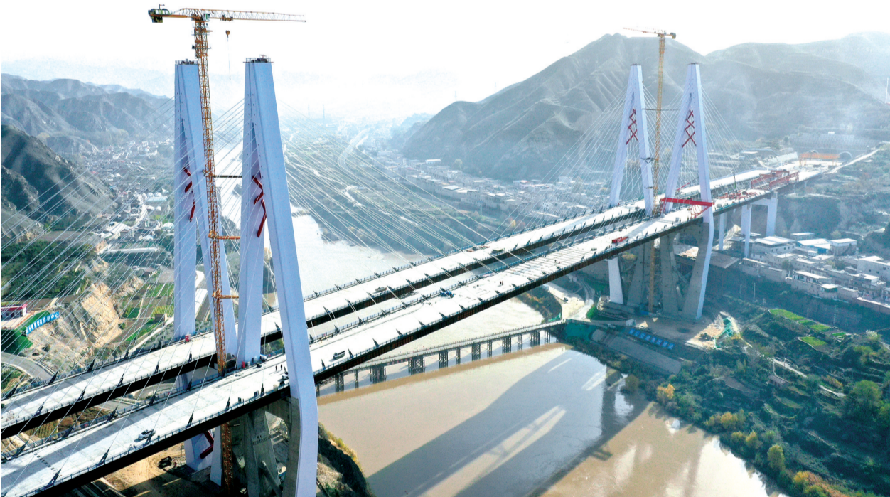
近日,甘肃首座双向八车道黄河大桥——G312线清水降至傅家窑公路桑园子黄河大桥顺利合龙。桑园子黄河大桥位于榆中县黄河桑园峡谷,总投资9.61亿元,全长959米,主跨328米,桥塔采用菱形“双子塔”结构,南塔、北塔分别高152米、133米,是清傅一级公路的控制性工程。它的顺利合龙,为清傅一级公路早日全线建成运营打下了坚实基础。本报记者 王钊 摄影报道
